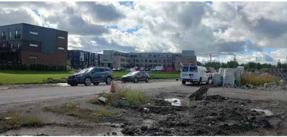
Photo à gauche : Le secteur Lachine-Est en construction, septembre 2022
