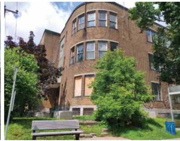
Photo à droite : La façade de l'ancienne école Allion, dans le Village-des-Rapides de LaSalle, située au coin de la rue Édouard et de la 4 e avenue, août 2023.
