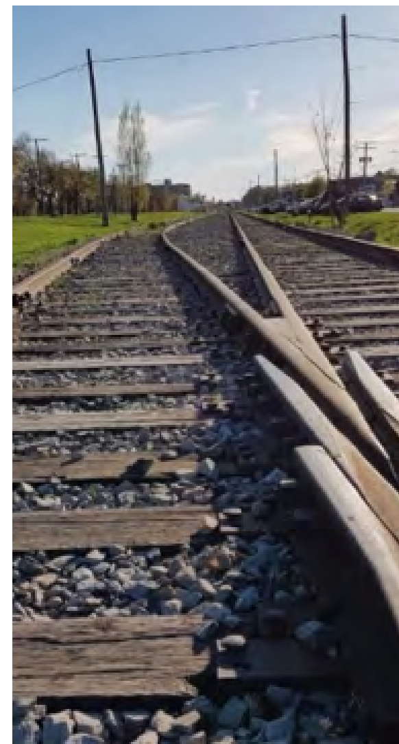
Emprise ferroviaire le long de la rue Victoria
