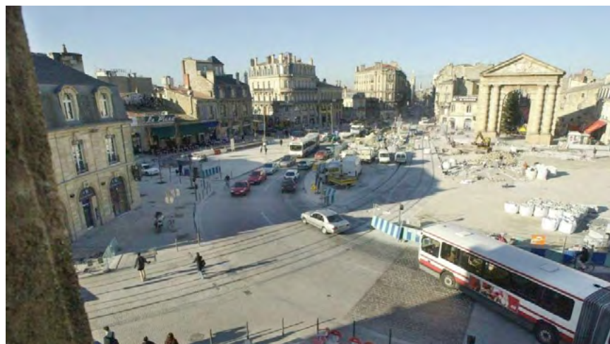
Le 9 décembre 2003, travaux Place de la Victoire à Bordeaux (Crédit photo : Guillaume Bonnaud)
